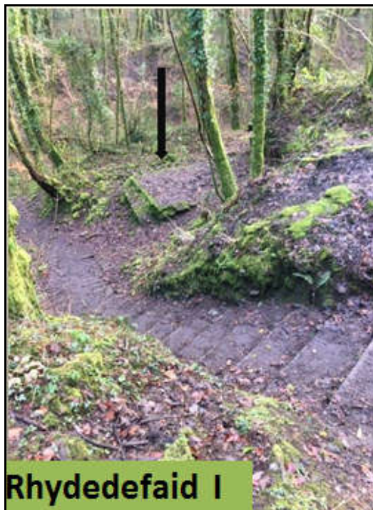
Capped Rhydydefaid I shaft
