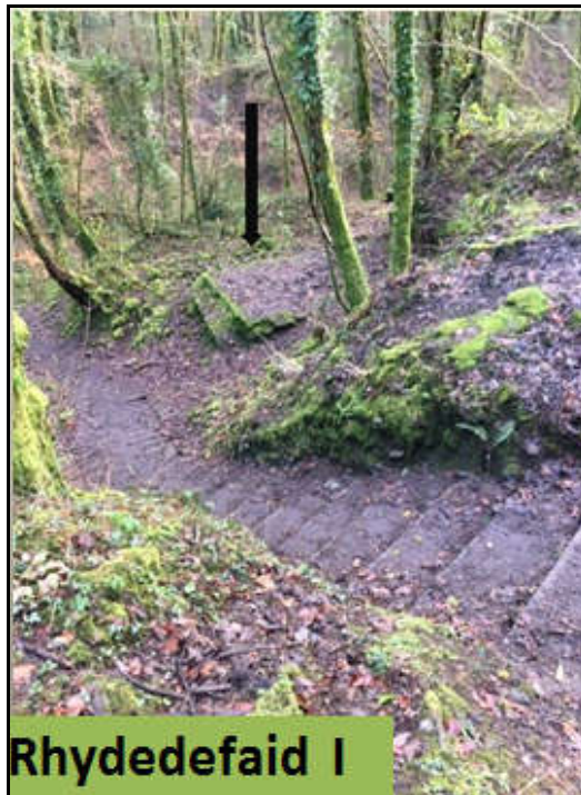
Capped Rhydydefaid I shaft
